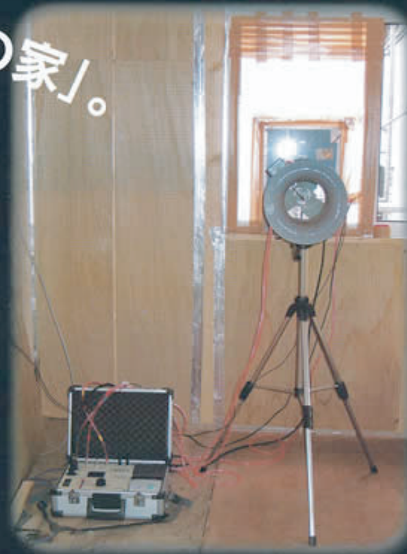
気密測定器により、建物の気密性能を測定
