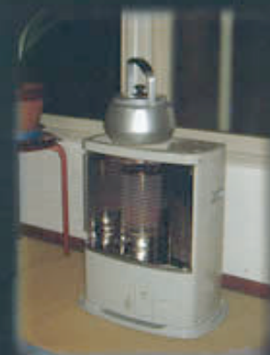
石油ストーブから発生する水蒸気が結露を引き起こす原因のひとつでした。
